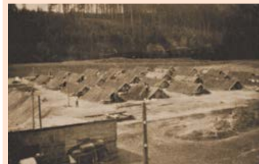
Das Erdhüttenlager in Regau bei der heutigen Buchbergsiedlung.
